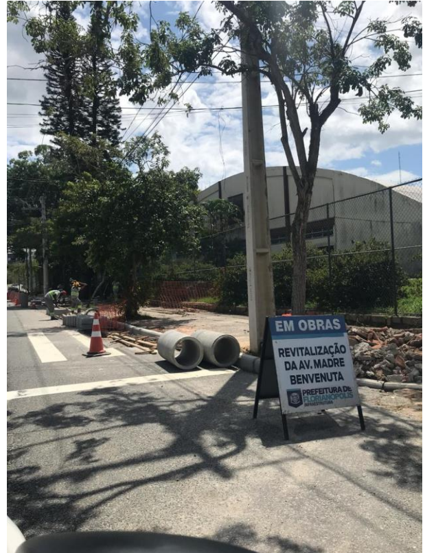
Obras receberam vistoria do controle interno
