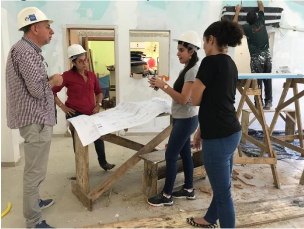
Visita às obras da creche Caetana Marcelina Dias
