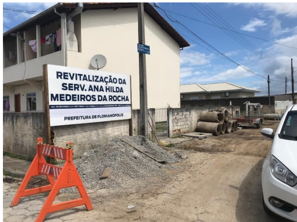
Obras da servidão Ana Hilda Medeiros da Rocha
