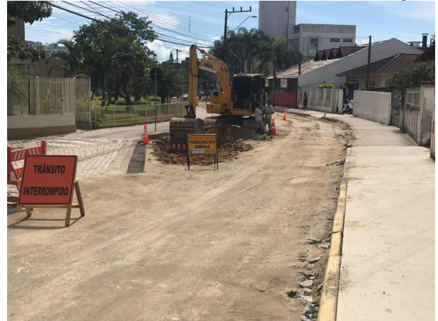
Rua Salvatina F. dos Santos, no Itacorubi em obras
