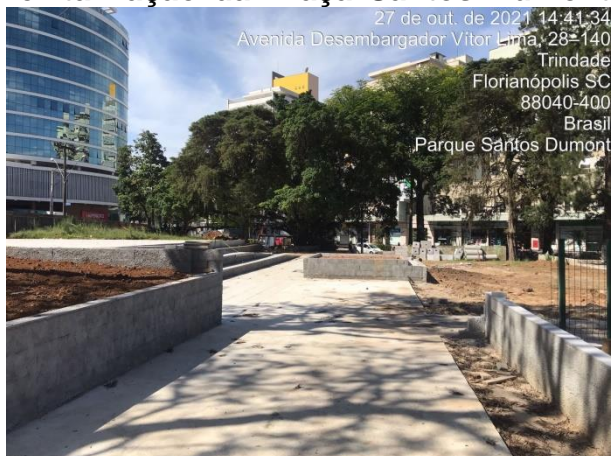
SMTAC visitou obras da Praça Santos Dumont
