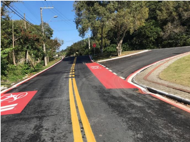
Obras na Rua Jurerê Tradicional
