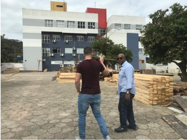
Técnicos visitam obras na UPA
