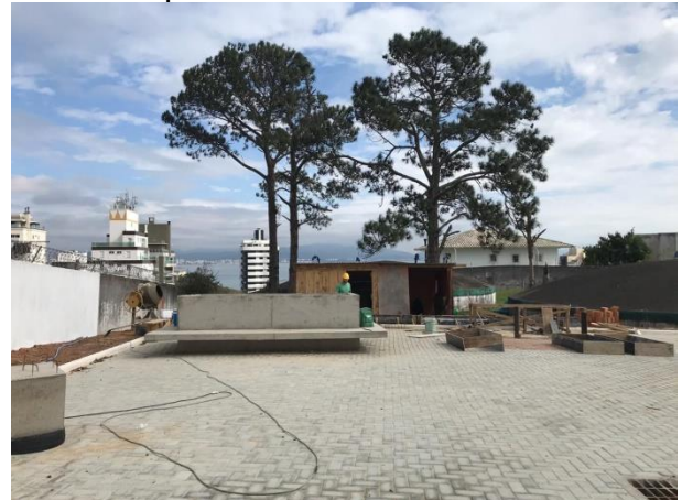
Obras na Praça Nova Trento
