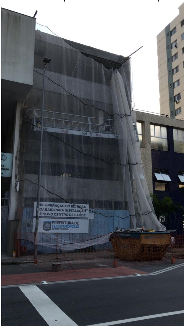
Visita a obra de reforma de prédio foi realizada dia 11
