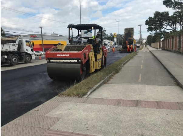
Avenida Madre Benvenuta em obras
