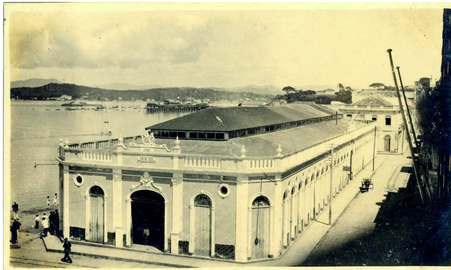
Figura 6 - Mercado Público antes da construção da segunda ala, ano 1922.
