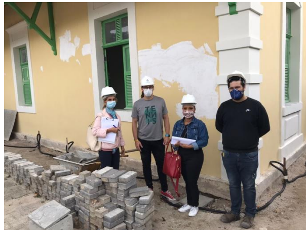
SMTAC visitou obras do Casarão Bento Silvério
