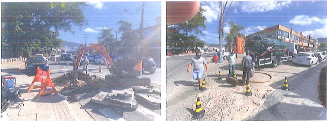
Figura 1 – Conserto do poço de visita do SES Lagoa da Conceição no dia 19/05/2020.
