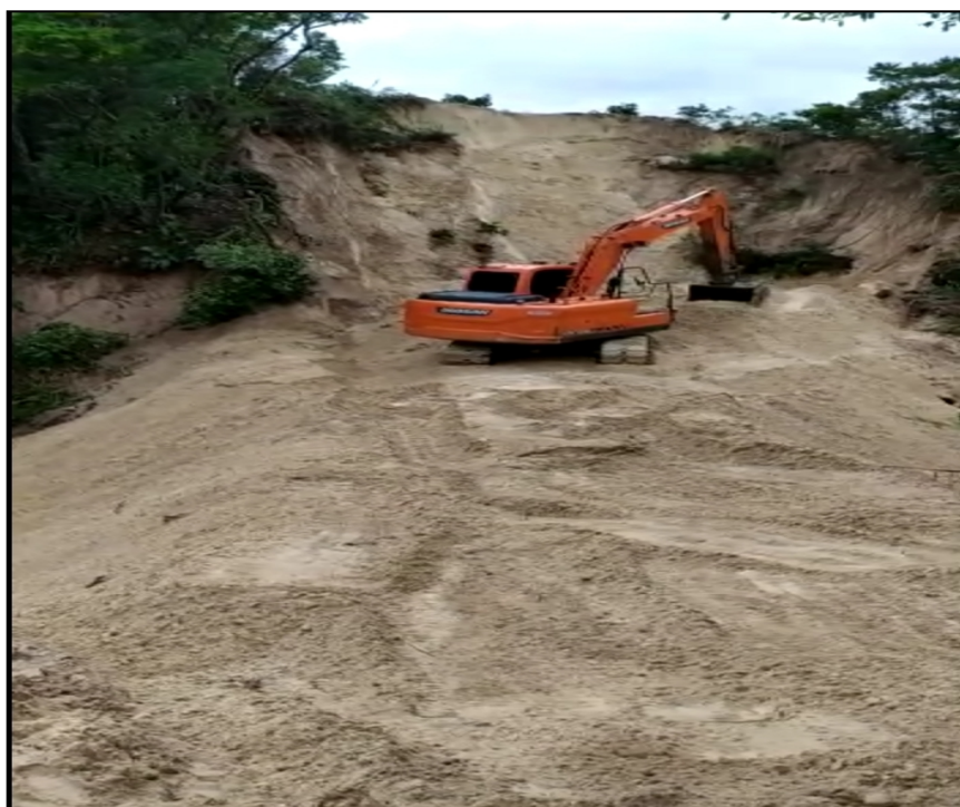
Figura 2 - Contenção das dunas com retroescavadeira
