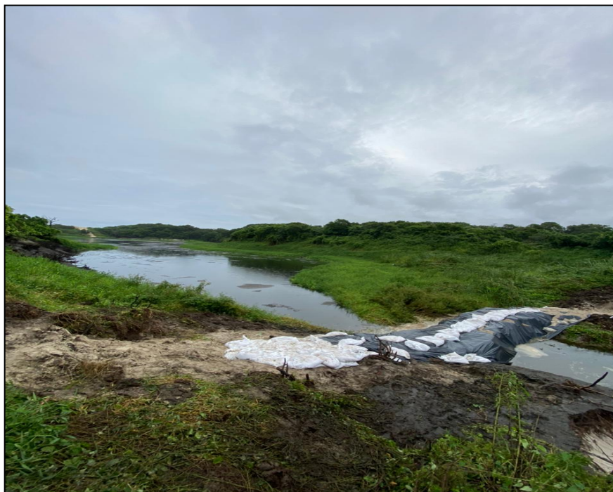
Figura 1 - Contenção com sacos de areia. Fonte: Arquivo CASAN.
