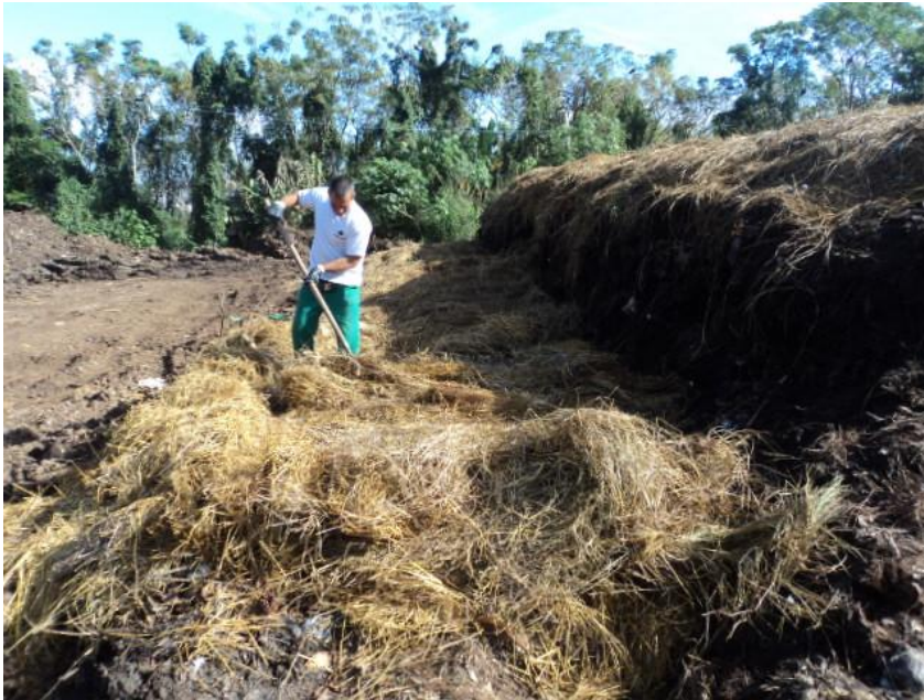
Foto 01 Trabalhador preparando berço para deposição de resíduos orgânicos. ao Lado leira já em processo de maturação.
